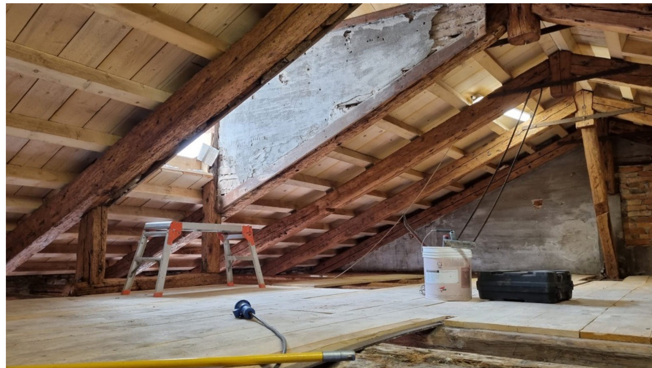
rifacimento struttura secondaria sottotetto
