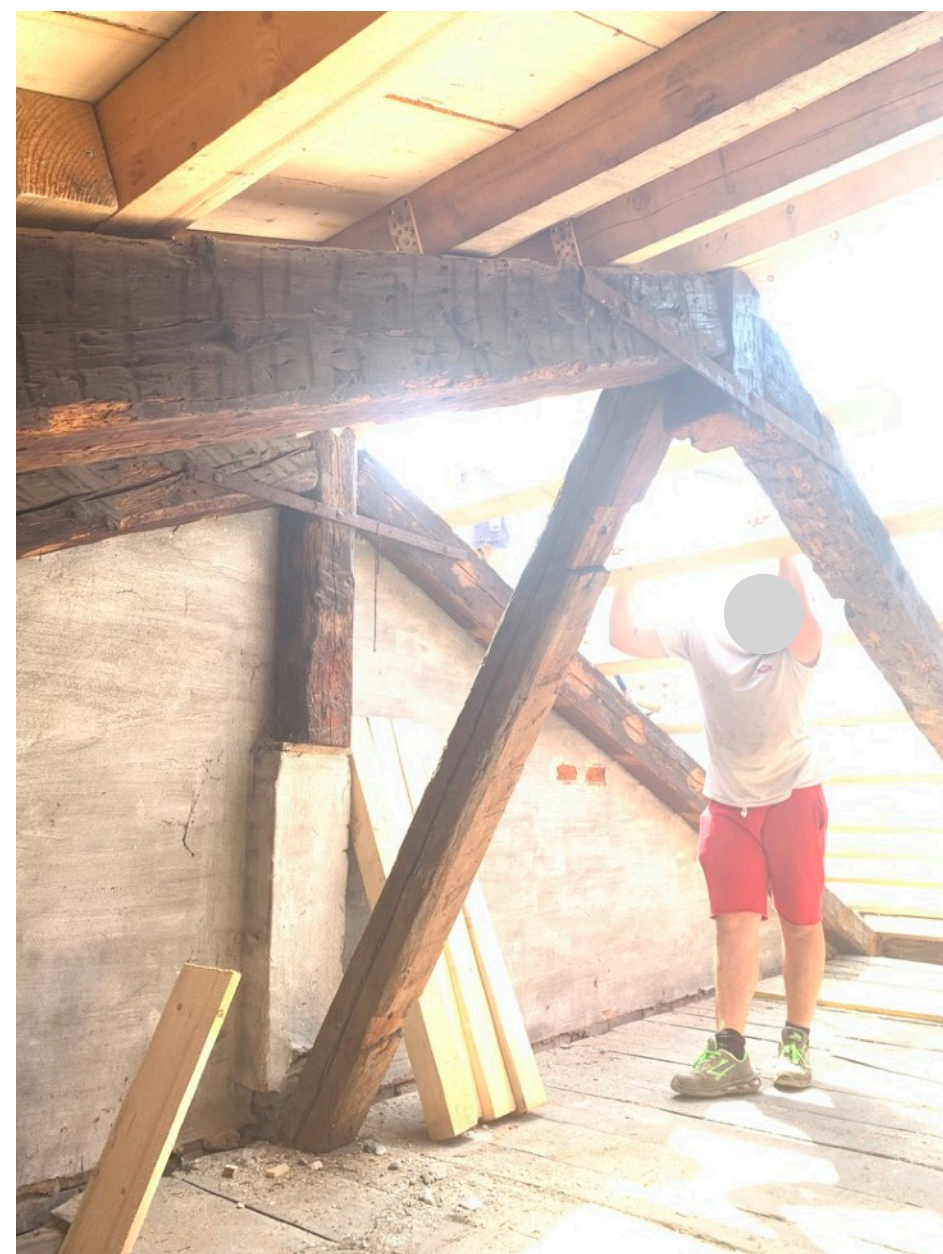
rifacimento struttura secondaria copertura
