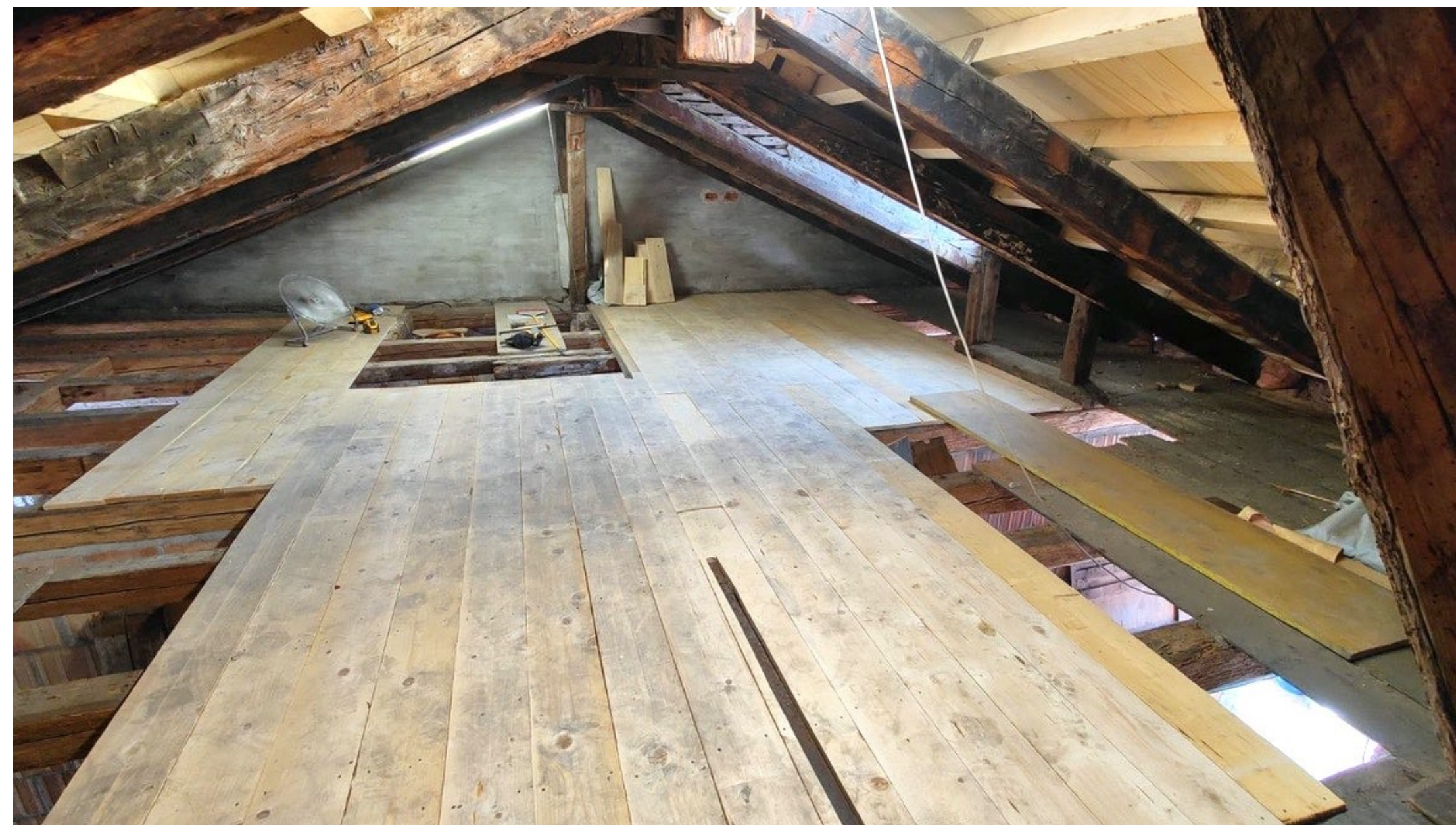
rifacimento struttura secondaria sottotetto
