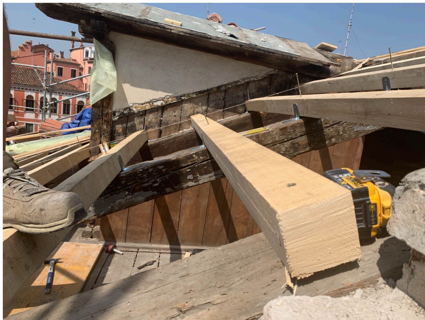
rifacimento struttura secondaria copertura
